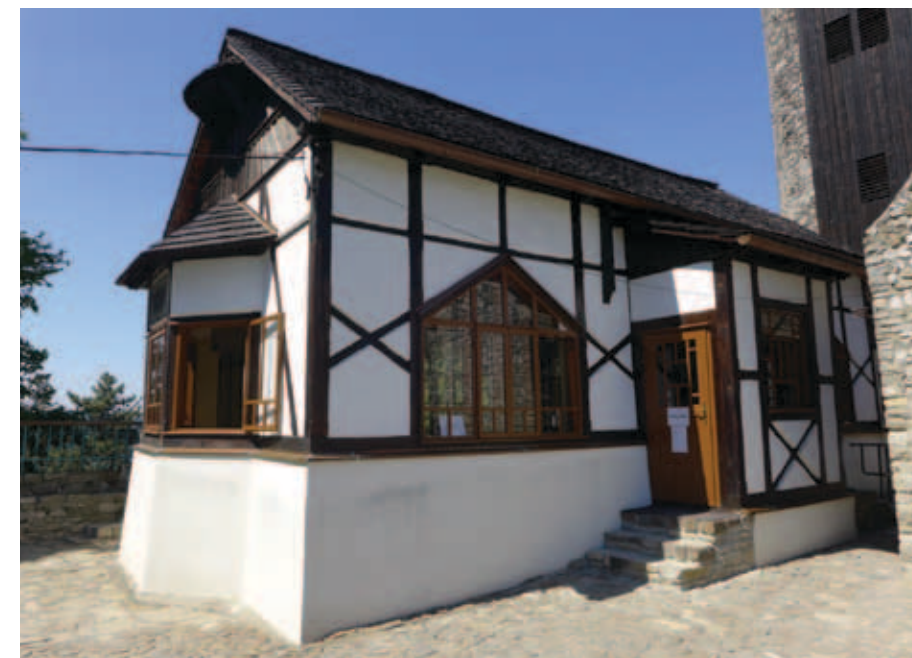
Pohled na jihozápadní fasádu a levou část jihovýchodní fasády Jaroňkovy útulny (foto Markéta Jurašková, 2015).
