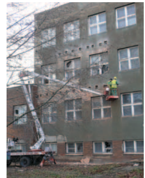
Průběh prací na zvyšování únosnosti železobetonových stropů v jižní části hlavního křídla (foto Marie Bartošová, 2014).
