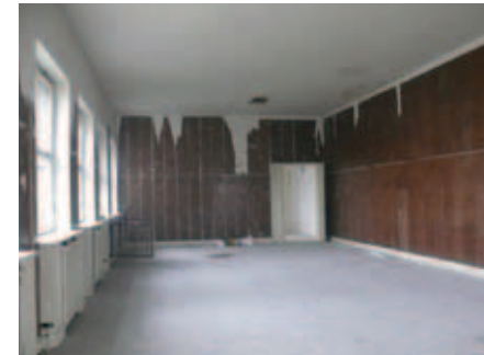
Zasedací síň během odstraňování tapet z dřevěných obkladů (foto Marie Bartošová, 2013).
