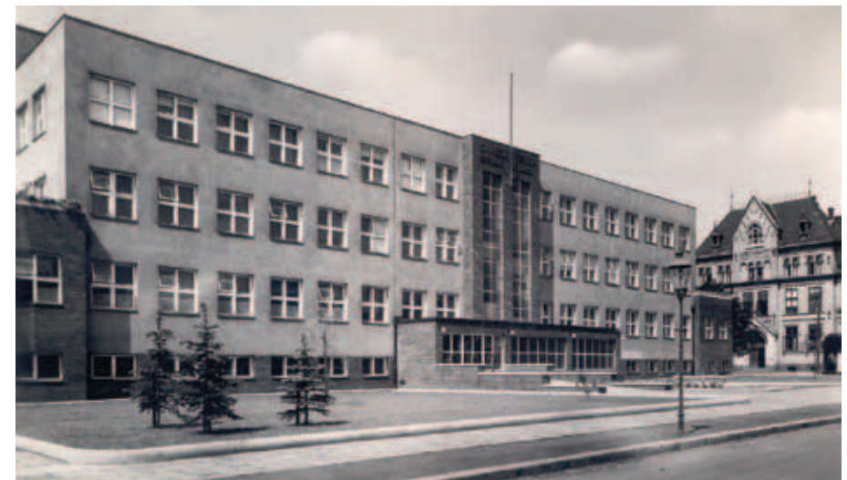
Karel Roštík – Jaroslav Stockar-Bernkopf, Okresní sociálně-zdravotní ústav v Moravské Ostravě, hlavní průčelí v kontrastu s historizujícím průčelím sousední hlavní budovy městské nemocnice (Slezské zemské muzeum, kolem roku 1934).
