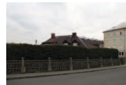
Pohled na zachované betonové oplocení zahrady dvojdому Pekařská 655/24 – 656/22 od severu, Hlučín (foto Martin Strakoš, 2015).
