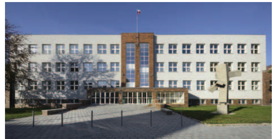
Hlavní průčelí hlavního křídla po obnově (foto Roman Poláček, 2015).
