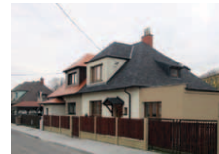
Dvojdům Pekařská 653/17 – 654/19, uliční průčelí od severu, Hlučín (foto Martin Strakoš, 2015).
